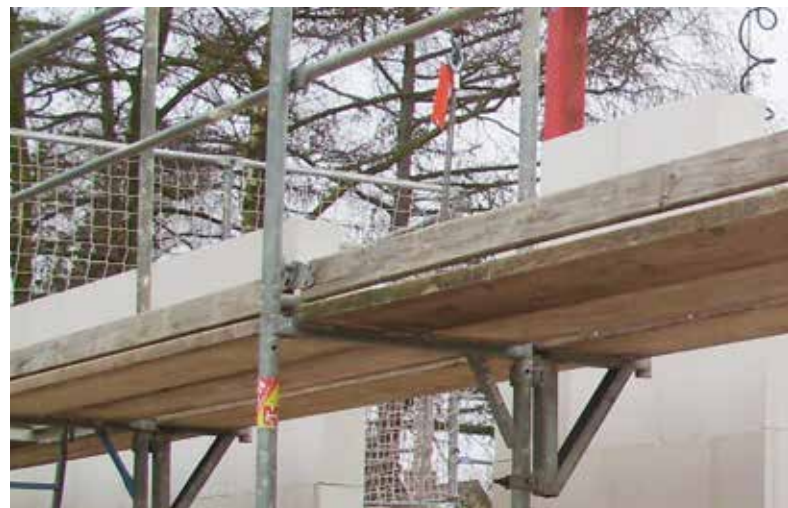
Viel Bewegung im Bauprozess - Fortschritte täglich zu beobachten
