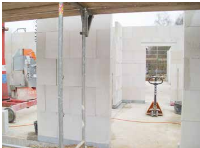
Einblicke in den Rohbau in der 12. Kalenderwoche
